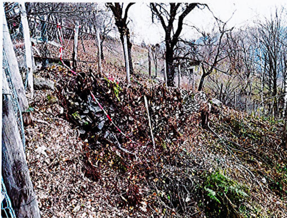
Figura 3 Muro in sasso da demolire e ricostruire
