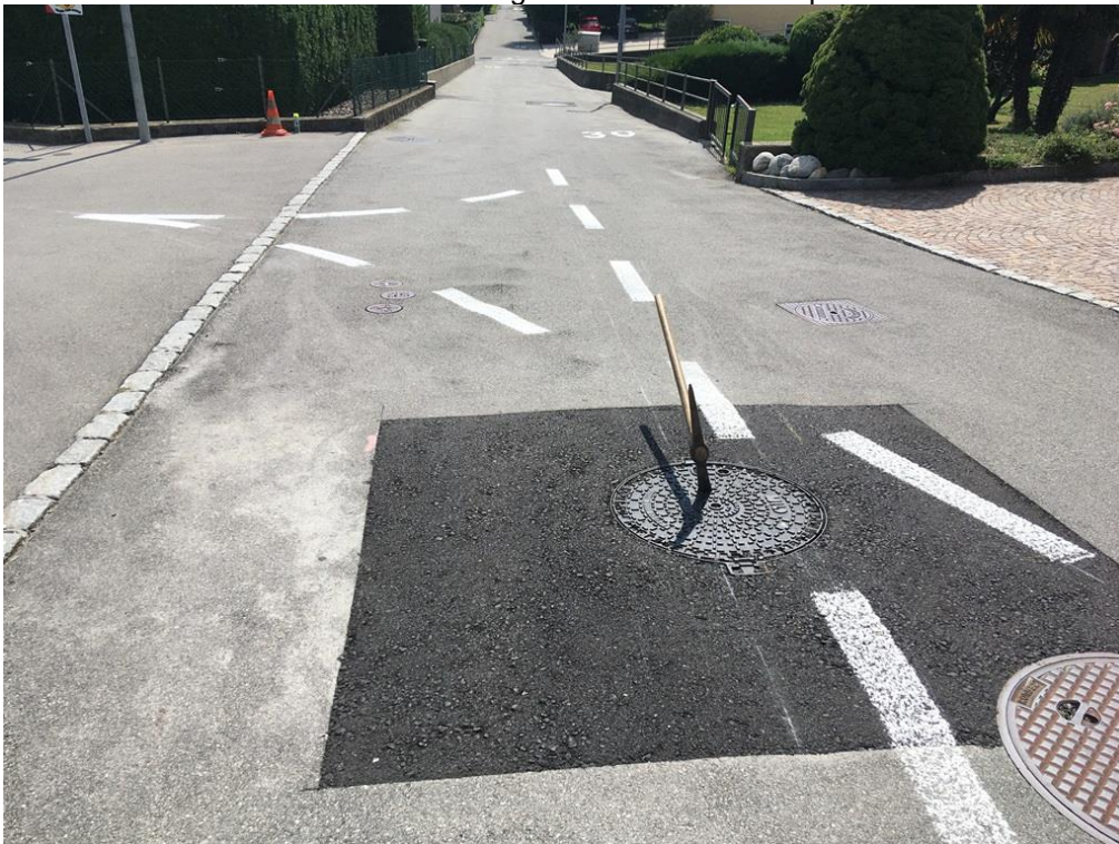
Foto no. 02 – Via ai Lungh vista da monte con pozzetto n. 113080
