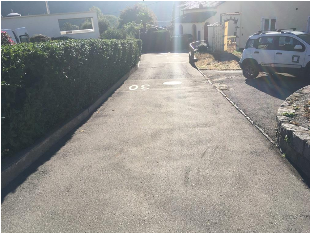
Foto no. 12 – Via alle Casette, vista da monte verso biforcazione della stessa
