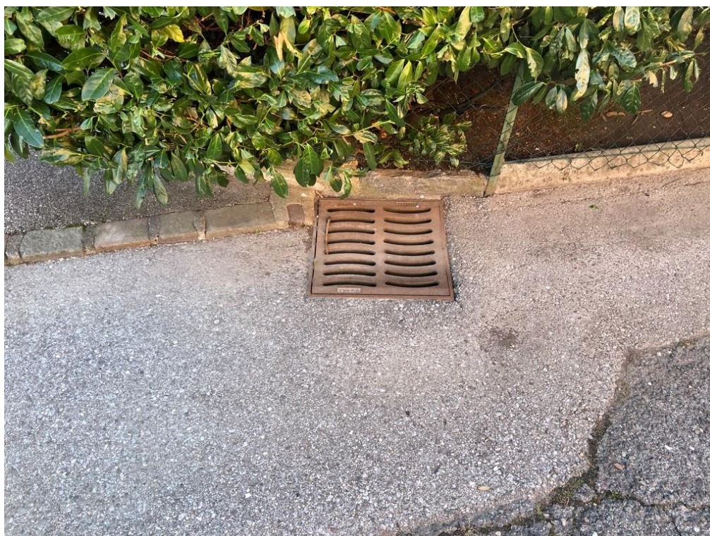
Foto no. 20 – Via Rovréd, caditoia stradale
