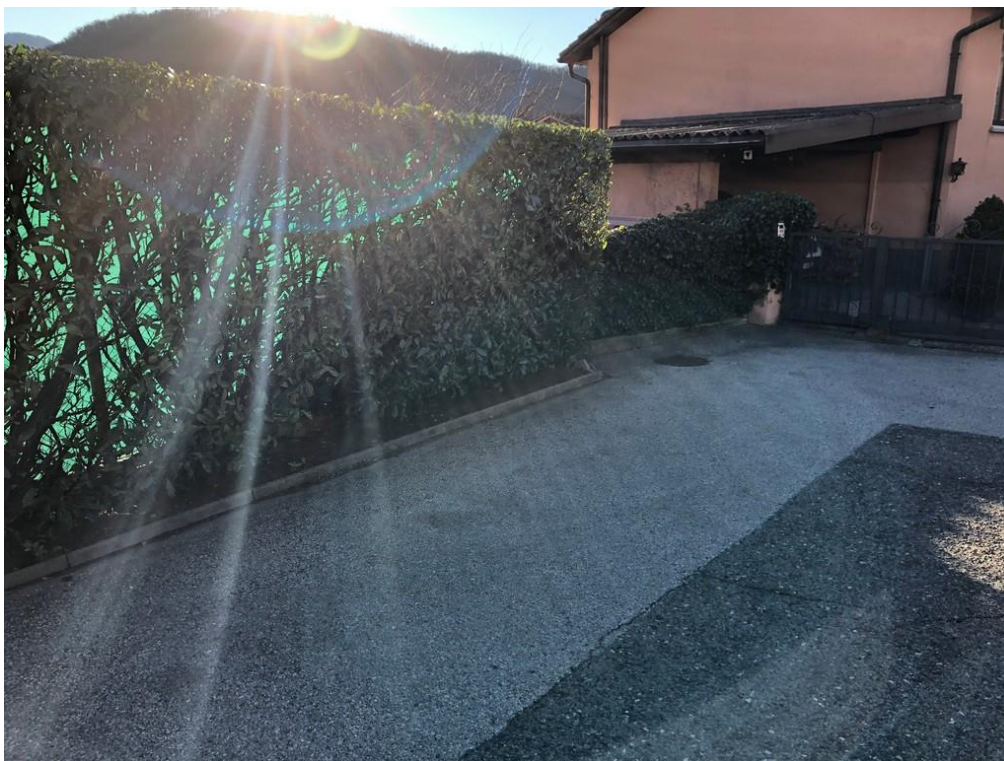
Foto no. 27 – Via Rovréd, stato della pavimentazione stradale
