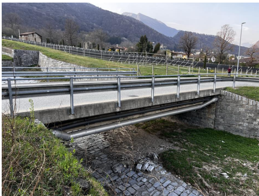
Figura 7: Ponte su Via Cantonale
