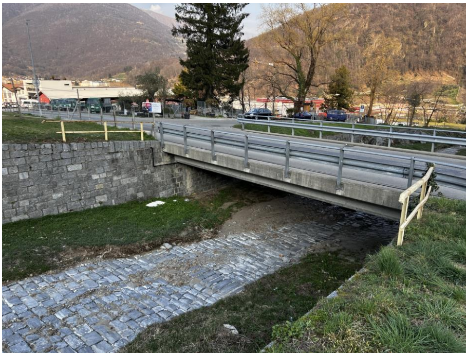
Figura 6: Ponte su Via Cantonale
