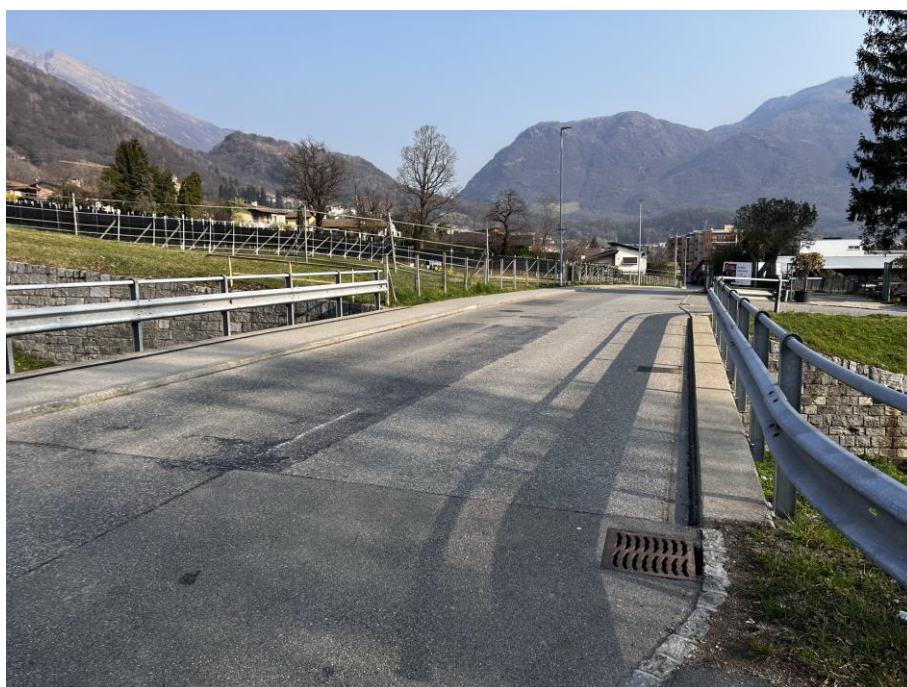
Figura 5: Ponte su Via Cantonale
