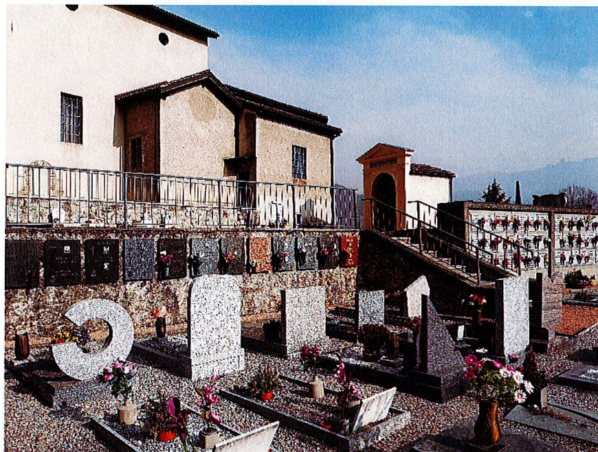
Figura 5: Muro in sacco esistente
