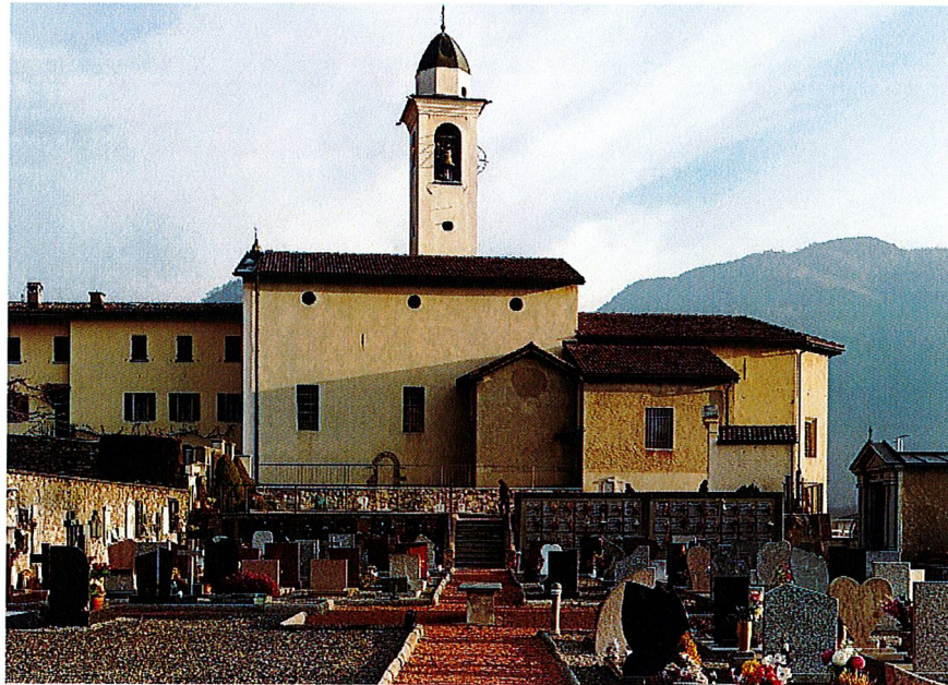
Figura 6: Fronte da Cimitero verso Chiesa – Stato di fatto
