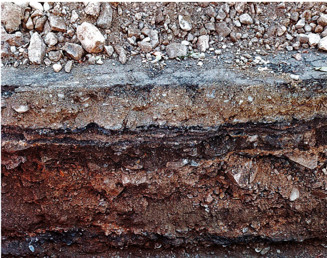
Figura 3: stratigrafia soprastruttura esistente
