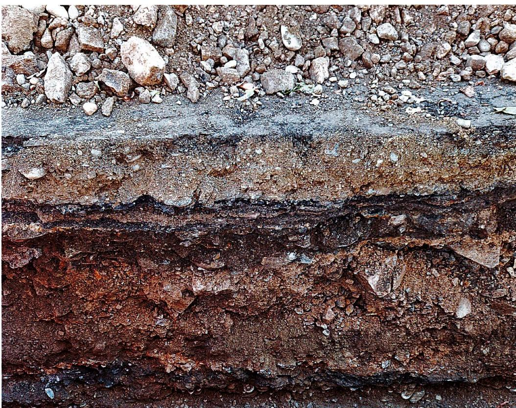
Figura 3: stratigrafia soprastruttura esistente
